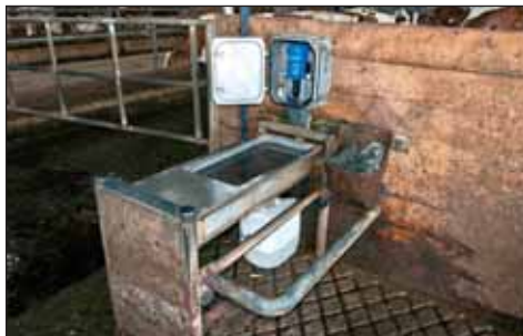
Prietokový dávkovač DOSATRON aplikuje TIRSAN-u 1312 do vody ...
